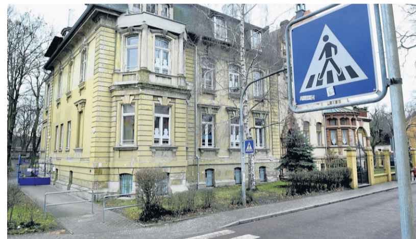
In diesem Gebäude werden die Schüler derzeit unterrichtet.
